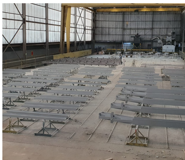
Vigas metálicas das arquibancadas.
